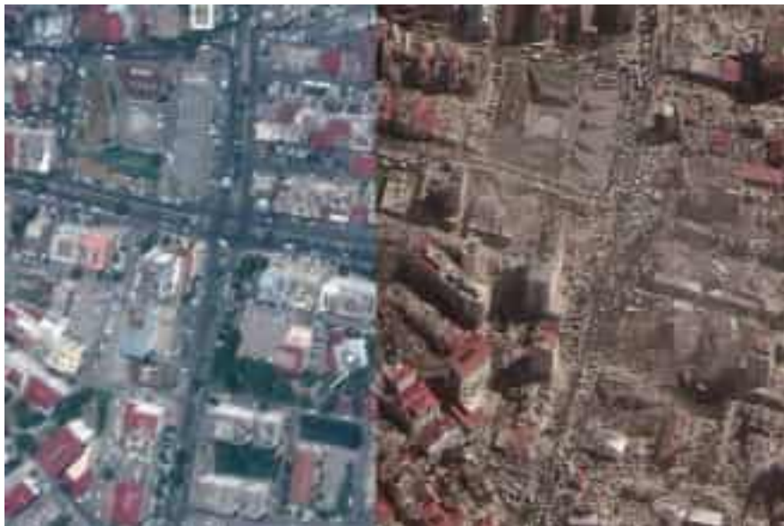
Figura 2. Daños ocasionados a la infraestructura construida y el fondo habitacional
