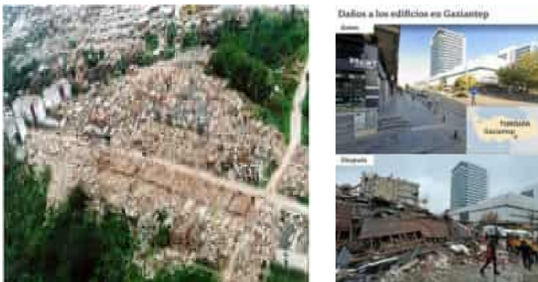
Figura 7. Izquierda: Daños del sismo del año 1989 en Armenia, Capital de Quindío en Colombia. Fuente: https://www.calendario-colombia.com/fotos_eventos/2015-10-17-terremoto-eje-cafetero.jpg ; Derecha: Daños del terremoto ocurrido en Turquía en el año 2023, ciudad de Gaziantep, antes y después. Fuente: teletica.com/bbc-news-mundo/terremoto-en-turquia-y-siria-6-fotos-del-antes-y-despues-muestran-escala-de-destruccion_328700
