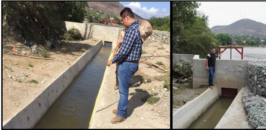
**Figura 3.13** Compuerta y canal rectangular para la derivación del agua.
