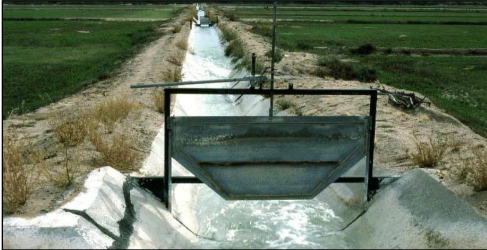
**Figura 1.3** Riego superficial con canal y compuertas de regulación.
