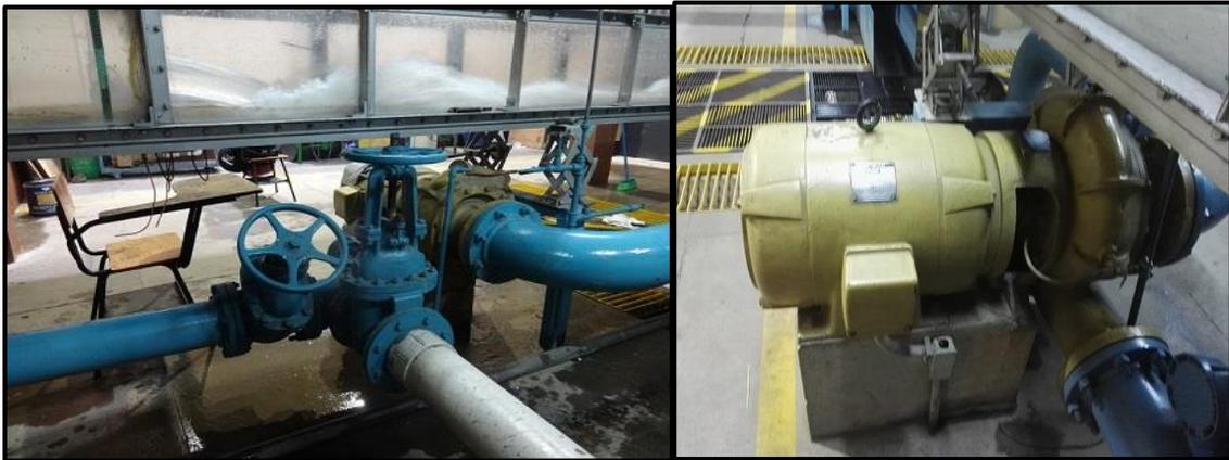
**Figura 2.2** Sistema recirculación con la bomba centrífuga.
