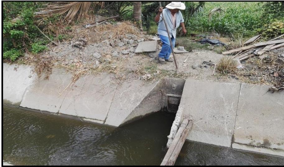
**Figura 3.14** Canal de sección trapecial y compuerta lateral.
