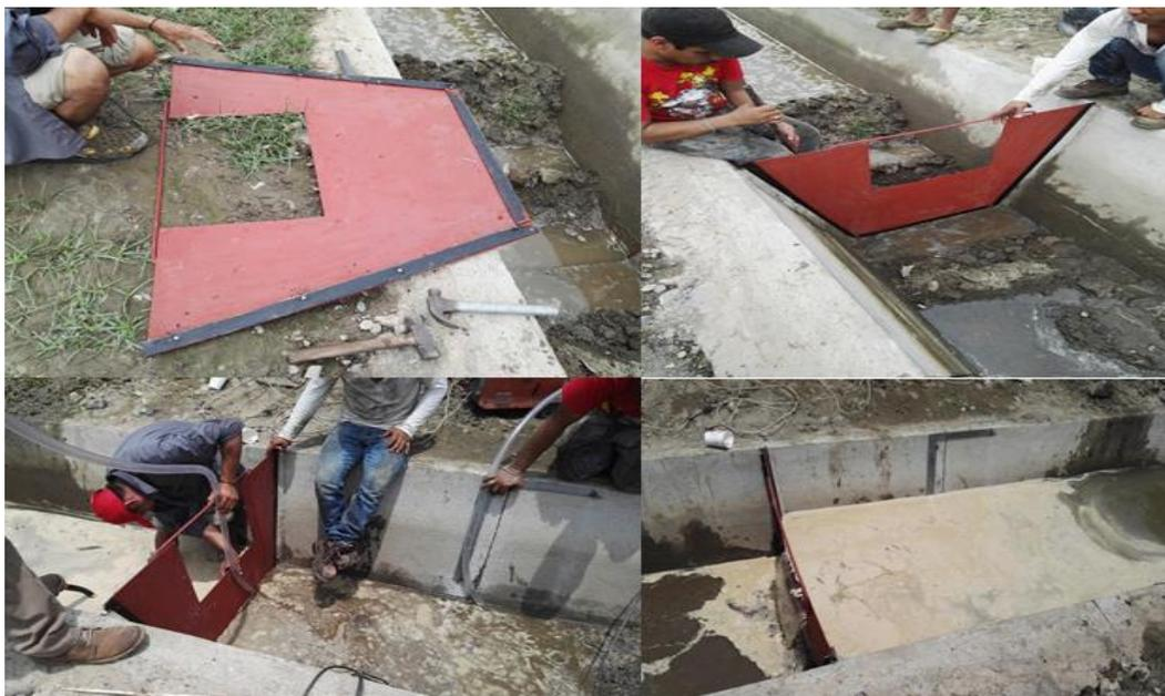
**Figura 3.15** Proceso de instalación y prueba del vertedor en el canal de riego.
